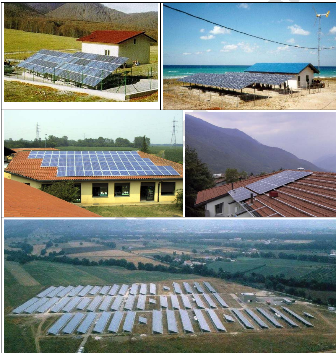
Figura 8.7 Varie tipologie di impianti fotovoltaici: alimentazione di utenza isolata [1], alimentazione di comunità isolata, tetti fotovoltaici e centrali fotovoltaiche [1].
