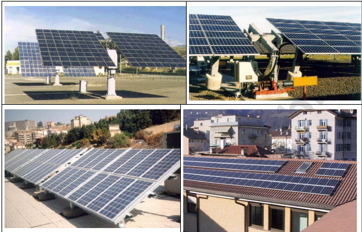
Figura 4.1 - Varie tipologie di strutture di sostegno per moduli fotovoltaici: Inseguimento solare su due assi, inseguimento su un asse [1], struttura inclinata su cavalletti e struttura inclinata su falda.
